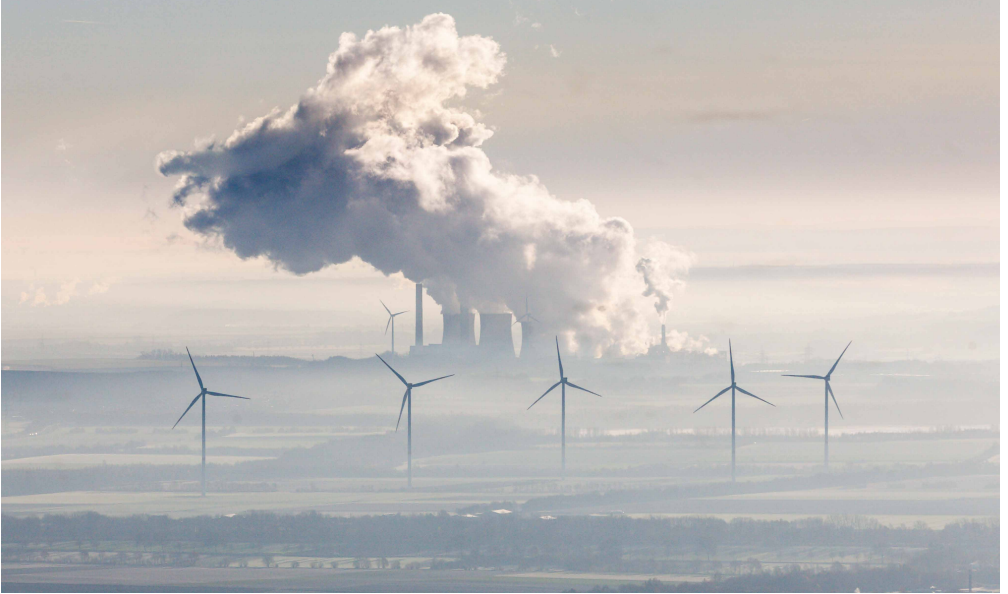
Luftaufnahme des Braunkohlekraftwerks Weisweiler im Rheinischen Braunkohlerevier
