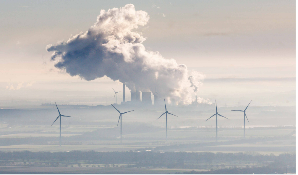
Luftaufnahme des Braunkohlekraftwerks Weisweiler im Rheinischen Braunkohlerevier
